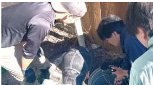
シオンキャビン汚水ポンプ交換工事 工事完了日：2024年10月1日 施工業者：黒沢燃料
